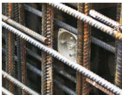
Víčko KBV připevněné na bednění.
