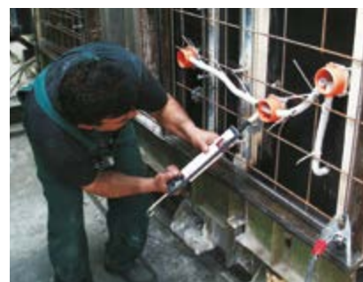
Utěsnění prostupů (tmel).
