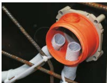
Namontované ohebné trubky do tělesa KBT.
